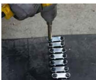
9| Ziehen Sie die Muttern\* mit dem Schraubendreher, der mit dem Anzugsschlüssel versehen ist, abwechselnd an den beiden Enden fest.
